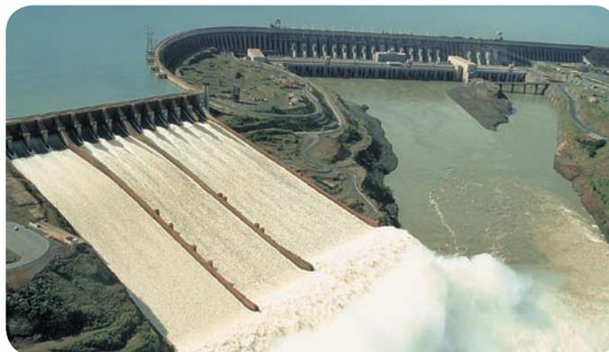
Usina hidrelétrica de Itaipu (Paraná), exemplo de central de geração de energia elétrica. Na foto, em primeiro plano vê-se o vertedouro, por onde a água escoo do reservatório (a montante da barragem) para a saída de água (a jusante), controlando o desnível. Esse controle é fundamental para o funcionamento da usina.
