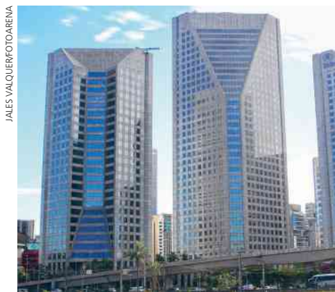
O edifício à esquerda na foto lembra um poliedro não convexo; já o edifício mais alto, à direita, lembra um poliedro convexo. São Paulo (SP), 2016.
